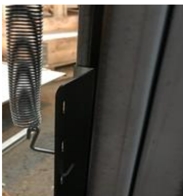
Рекомендуемое крепление пружины внизу.
