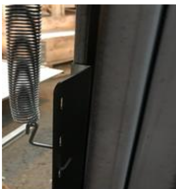
Рекомендуемое крепление пружины внизу.
